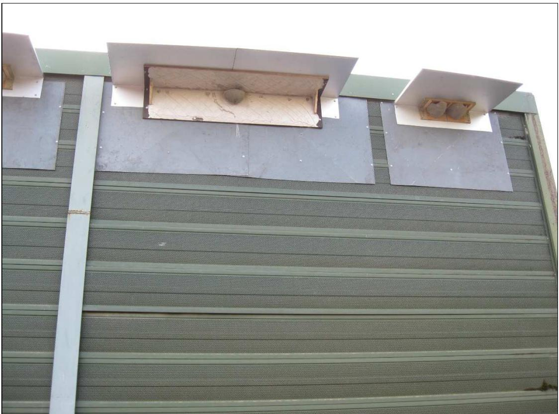
Abbildung 3: Montage der Rauch- und Mehlschwalbennester
